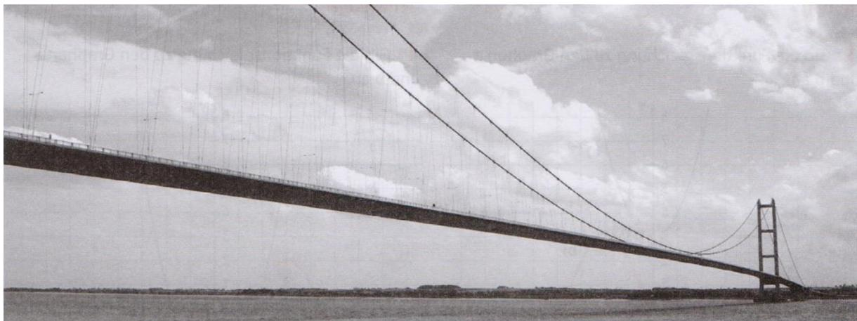
Das Stahlseil hängt parabelförmig zwischen den Brückenpfeilern.
